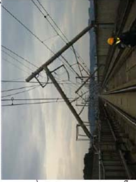
【電化柱の折損】(古川～くりこま高原)
